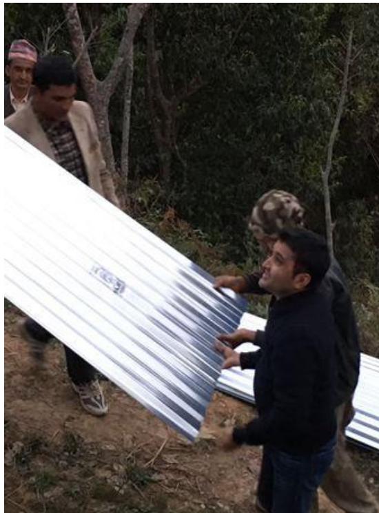
Wiederaufbau zerstörter Häuser in der Erdbebenregion
